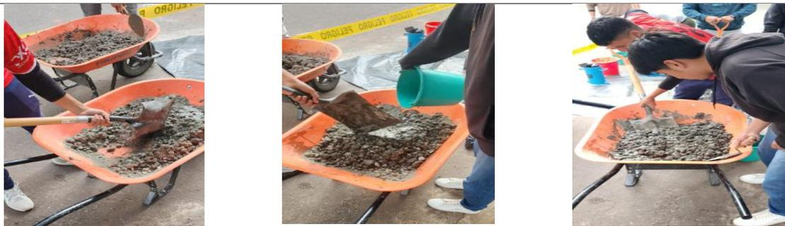
*Nota:* Mezclado de los materiales para la elaboración del hormigón.
